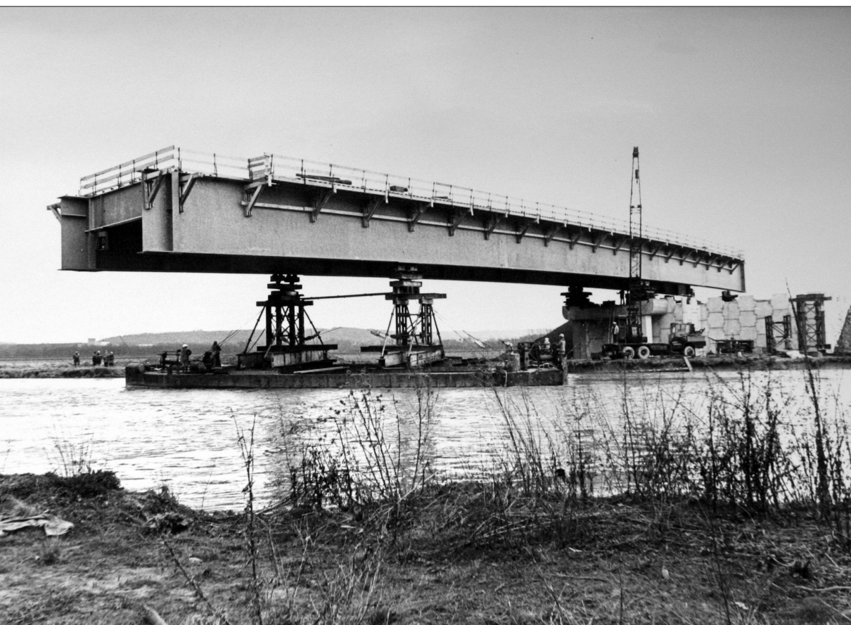
Début du lancement du pont. L'ensemble prend appui sur la culée de rive gauche et sur une ossature placée sur deux barges jumelées. Un dispositif de poussage est installé à l'arrière pour déplacer l'ensemble qui doit ainsi traverser la rivière. Dans les barges, quatre treuils reliés aux berges guident le pont. On voit que les ossatures support ne sont déjà plus verticales (Arch. DDE).
