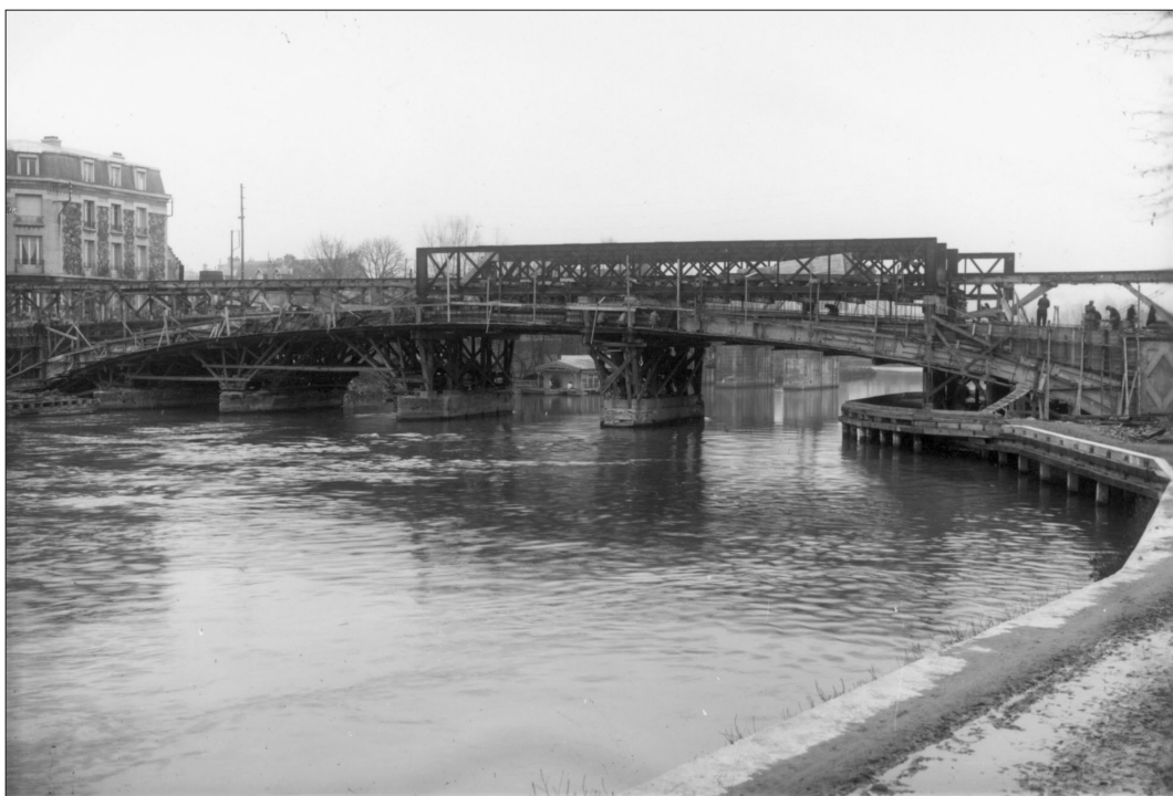
Construction du nouveau pont des Anglais. On a utilisé les deux travées Pigeaud pour servir de support des coffrages nécessaires au coulage du béton armé (Fonds Vergnol, SAHS).
