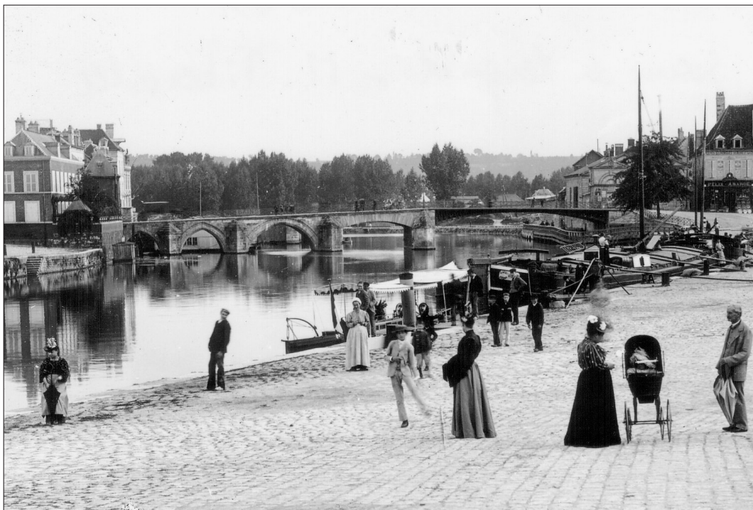
Le pont dans les années 1900. Les modifications effectuées sont bien lisibles. A gauche les arches médiévales. Au centre la passe marinière voûtée vers 1800. A droite la travée métallique installée en 1886 (Fonds Vergnol, SAHS).
